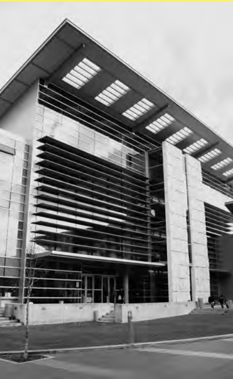
La biblioteca, aulas de teóricas y vistas exteriores de la Universidad de Otago, Nueva Zelanda.
