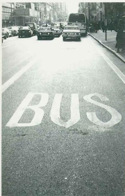
▲ Los mensajes que se pintan en el pavimento están diseñados para ser leídos a diferentes velocidades. Se utilizan letras condensadas para que se vean normales desde el vehículo; un conductor de auto verá las letras menos condensadas que un colectivo.
